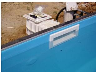
Fase 7: Posa del telo in PVC con ancoraggio tramite profilo in alluminio e fettuccia
